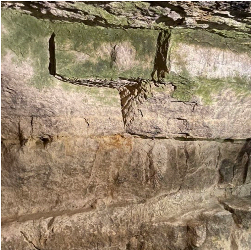
Figur 4. Kalksten i beige till ljusgrå färger. Sprickor i bild är ställvis och periodvis vattenförande beroende av väderförhållanden. Sprickorna utformar ett nästan rätvinkligt mönster och syns som nästan svarta streck. (Foto N. Rantakokko, kalksten under Paris, 2022)
